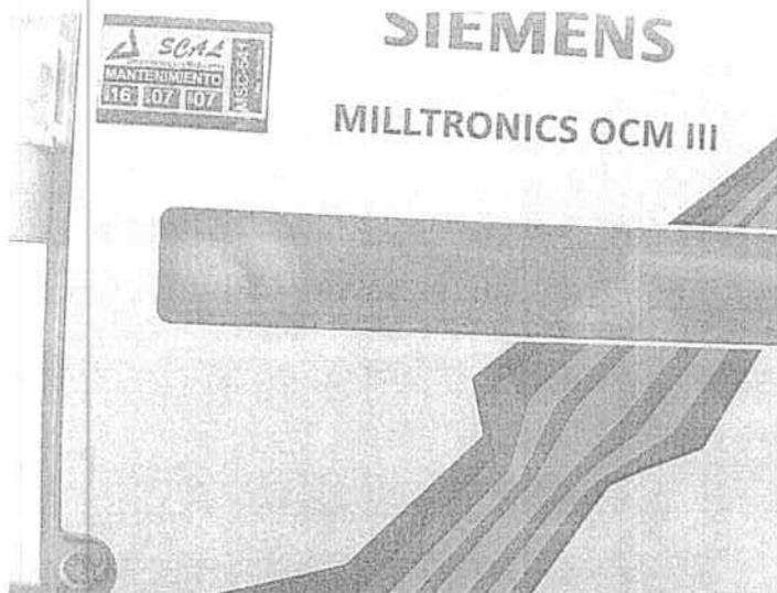
Fotografía No. 2 Lectura de caudal en la canaleta Parshall = 154,17 m<sup>3</sup>/hora, lo que es equivalente a 42,82 Litros/segundo
